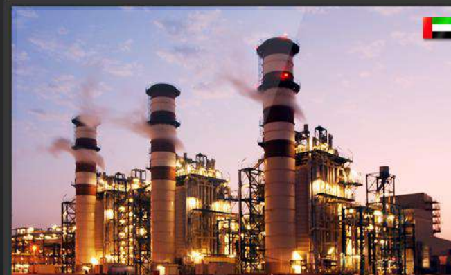
Shuweihat Plant (UAE)
